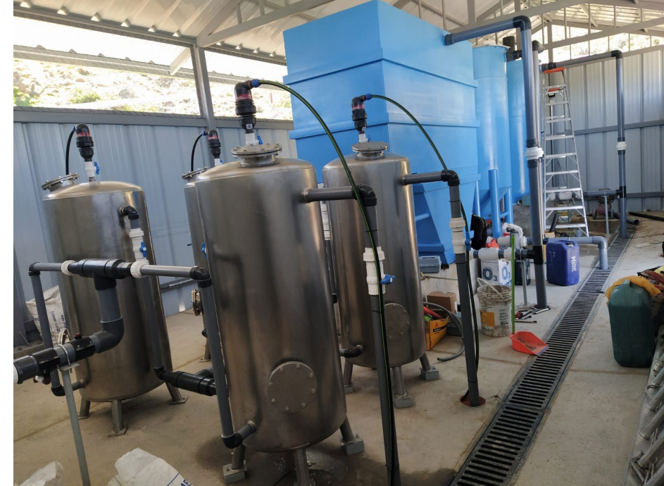
Planta en funcionamiento CC Coscore Torata – Moquegua Q_{max} = 0.65 - 1.5 lt/seg AngloAmerican Quellaveco
